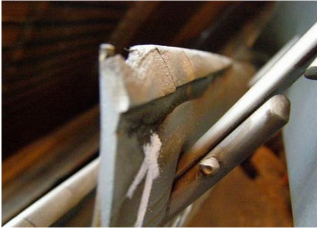
Slika 4. - Oštećenje od kapljica vode - „štitnik“
